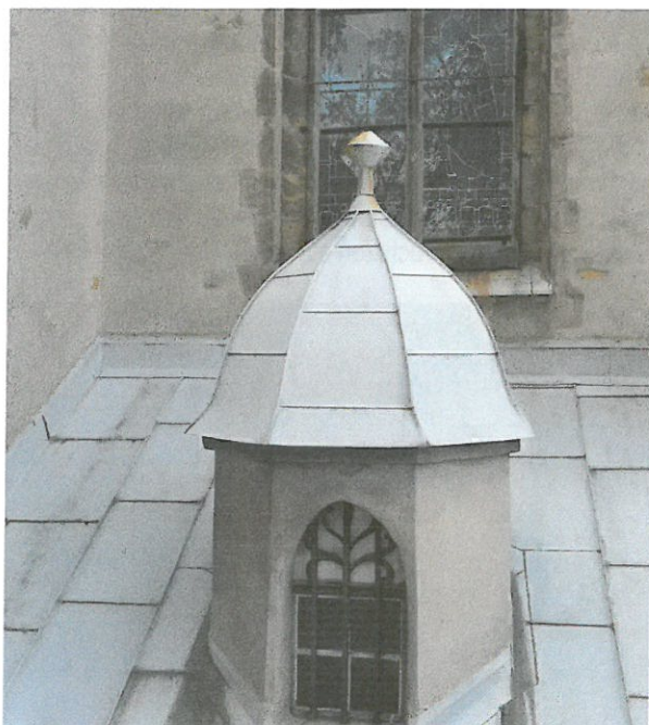
Pokrycie z blachy cynkowej na latarni
